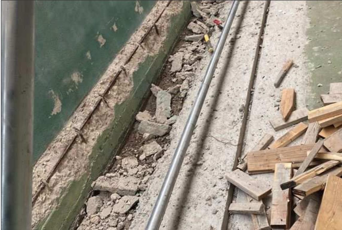
Sono stati inseriti in variante gli interventi necessari al trattamento delle armature, il ripristino dei copriferri e il rifacimento totale dell'intonaco previa demolizione e risanamento delle parti ammalorate.
